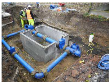
Pose de compteur de sectorisation
