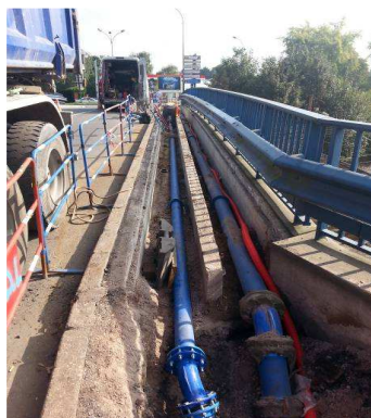
Pose de réseau sur ouvrage d'art
